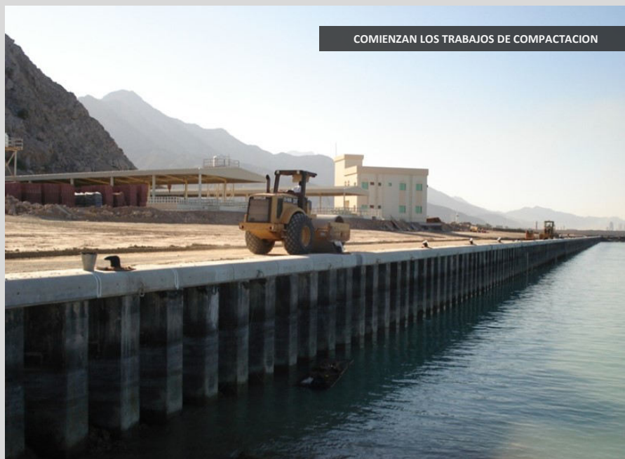
LA COMPACTACION FINAL LISTA CONTINUA AHORA QUE TODAS LAS PILAS DE HOJA Y LAS BARRAS DE ASIENTO ESTAN INSTALADAS
