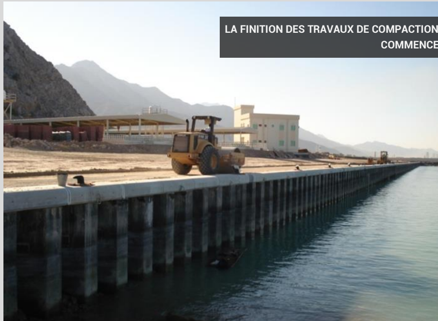
LE COMPACTAGE FINAL PRÊT CONTINUE MAINTENANT QUE TOUS LES TÔLES DE FEUILLES ET TIGES SONT INSTALLÉES
