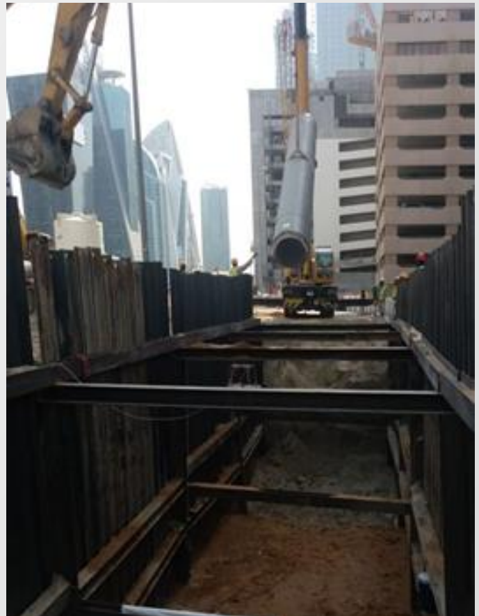
ESC TRENCH SHEETS INSTALLED AMIDST BUSY STREET IN DUBAI DOWN TOWN AREA POUR DE NOUVEAUX TRAVAUX DE POSE DE TUYAUX
