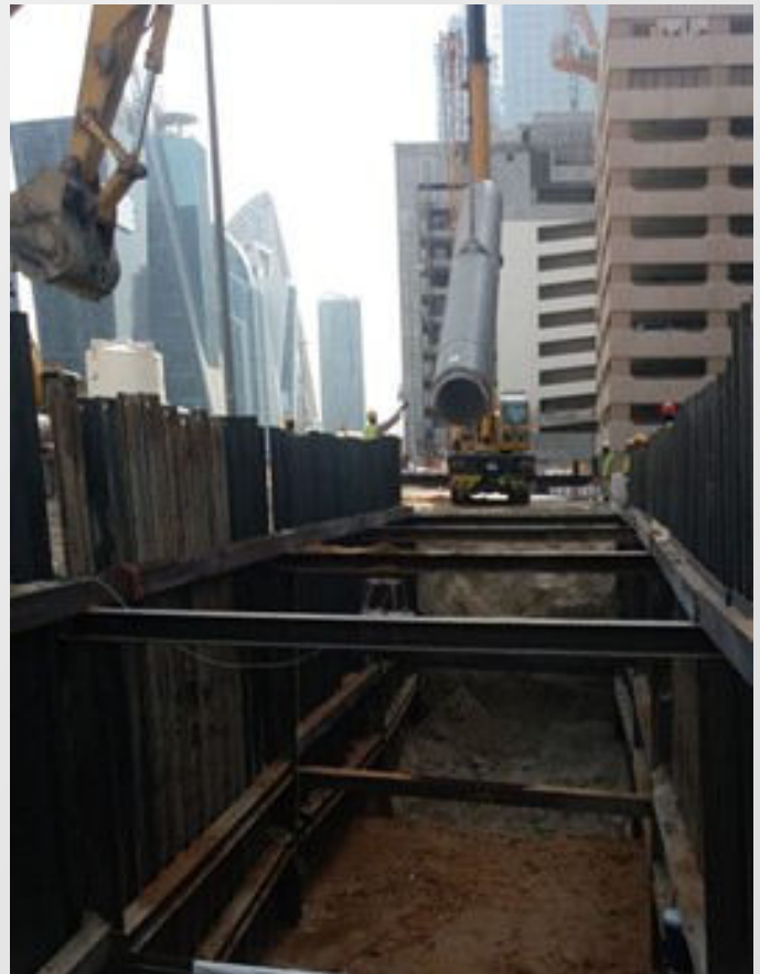
ESTACAS DA ESC INSTALADAS EM MEIO À RUA OCUPADA NO CENTRO DE DUBAI PARA NOVOS TRABALHOS DE INSTALAÇÃO DE TUBOS
