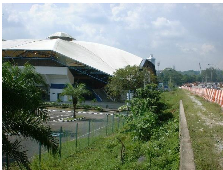
Mur 4 Avant Construction.
