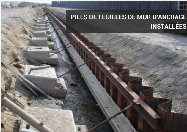
L'INSTALLATION FINALE DES PIEUX EN FEUILLE À LA PROFONDEUR EST EFFECTUÉE PAR LE MARTEAU HYDRAULIQUE IHC S90
