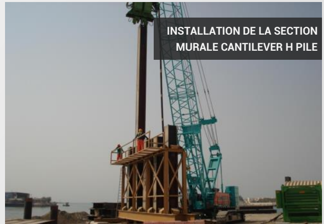
LEVAGE DES PIEUX EN PLACE POUR QUE L'INSTALLATION COMMENCE
