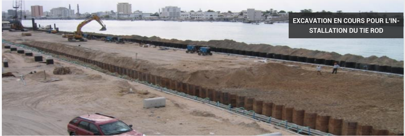
PILES DE FEUILLES DE MUR D'ANCRAGE INSTALLÉES
